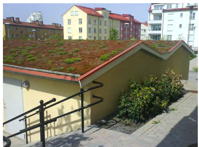
Gröna tak på garagebyggnader (Sweco).
