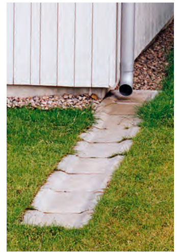
Gräsförsedd rasteryta för bibehållande av genomsläpplighet (Sweco). Stuprörsutkastare för infiltration på gräsmatta (källa: Peter Stahre, 2004, En långsiktigt hållbar dagvattenhantering, Svenskt Vatten. Foto: Ulf Thysell).
