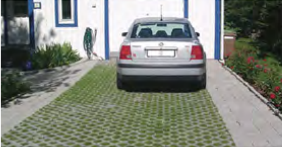
Gräsförsedd rasteryta för bibehållande av genomsläpplighet (Sweco). Stuprörsutkastare för infiltration på gräsmatta (källa: Peter Stahre, 2004, En långsiktigt hållbar dagvattenhantering, Svenskt Vatten. Foto: Ulf Thysell).
