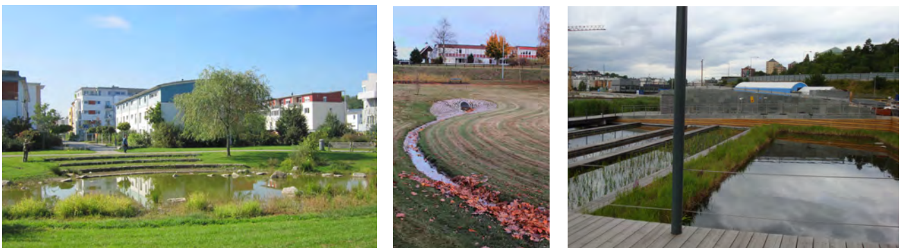
Dagvattendamm (Okidoki). Fördröjningsyta (Stockholm Vatten) Fördröjande bassänger (Stockholm Vatten).
