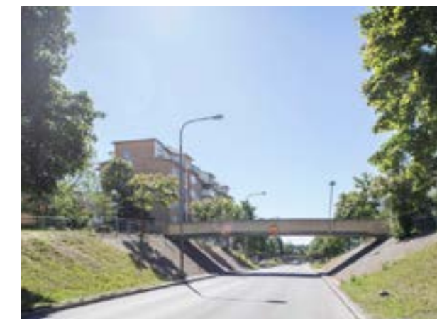
Rinkebystråket före och efter ombyggnationen
